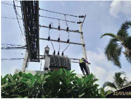
การตรวจสอบและซ่อมบำรุงหม้อแปลงไฟฟ้า
